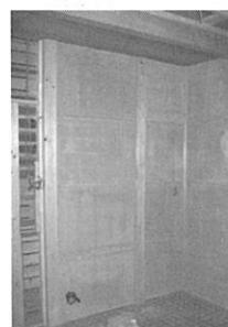
日本建築の壁下地となる荒壁は、調湿・調湿性などの多方面に優れていますが、一年以上の乾燥期間を必要としました。今回採用した荒壁パネルは乾燥いや構造用合板に比べ、高い変形性能を持ち幅ねり強さの点から同等以上の性能を持っているため町家や寺社などの伝統工法の創設・改修に優れた性能を発揮します。
