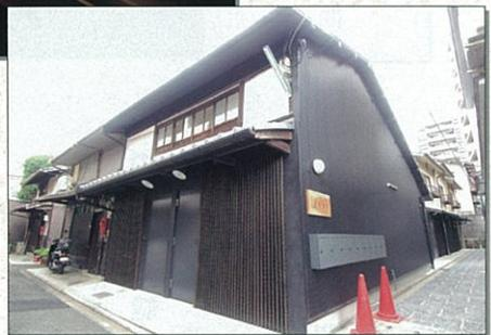
外観は、京町家の伝統的な雰囲気は残しながら、外壁を墨色の防火鋼板で強化している(写真右)
