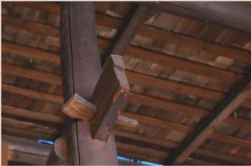
「仕口（しぐち）」と「継手（つぎて）」は、柱や梁の接続部において金物を用いず、二つの部材をつなぎとめる方法である。建築に限らず、家具など「指物（さしもの）」と呼ばれる木工の世界においては共通の伝統的手法と言える。材と材をこみ栓や車知などでつなぐものを「仕口」、断面同士を合わせつなぐものを「継手」という。「継手」は水平に接合したい部分に用いられる。接合部分の形状は様々で、施工部分に適した方法が用いられる。その種類は六十種類あると言われ、代表的なものには、腰掛け鎌継ぎ（こしかけかまつぎ）、金輪継ぎ（かなわつぎ）台持ち継ぎ（だいもちつぎ）などがある。
