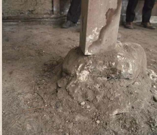
伝統工法が石場建てとも呼ばれる大きな理由。「一つ石（ひとついし）」や「葛石（かづらいし）」、これら基礎となる石の上に構造部が置かれているだけで、緊結されていない。現代の鉄筋コンクリートのような一体型の基礎とは大きく異なる点である。
