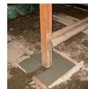
町家の特徴は基礎が無く柱が独立していること。玉石に乗っているだけの柱が強い地震によって玉石から落ちないように周囲をコンクリートで固めます。
