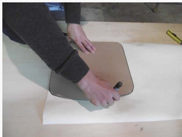
作業② 型紙を元にクロスをカットして糊付けし、5分ほど置きます
